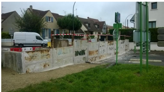
« mur de la honte », séparant Montesson de Sartrouville lors des crues de la Seine
